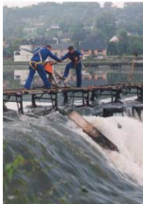
Manœuvres sur l'ancien barrage de Hastière © MET - D. 434 - 98/03315
