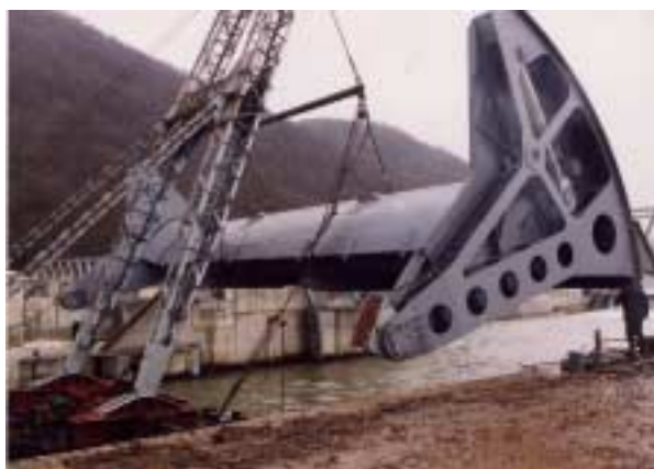
Pose de la première vanne sur le barrage d'Hastière © MET - D. 434 - 01/00595
