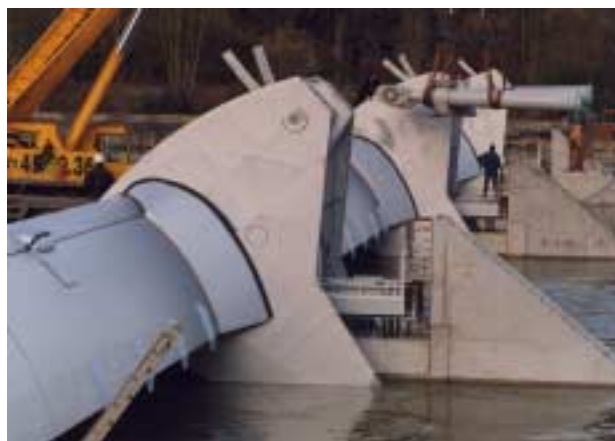
Mise en place des vannes au barrage de Waulsort © MET - D. 434 – 00/00248
