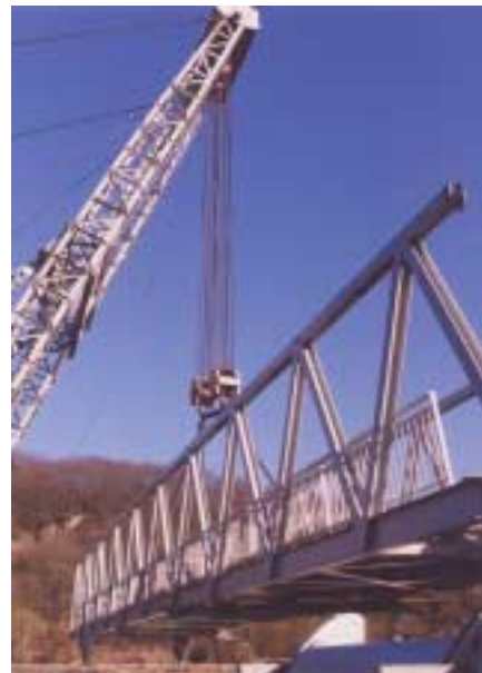
Pose de la passerelle à Waulsort © MET - D. 434 – 00/00283
