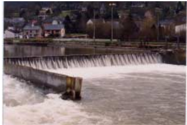
Ancien barrage d'Hastière © MET - D. 434 - 01/00578
