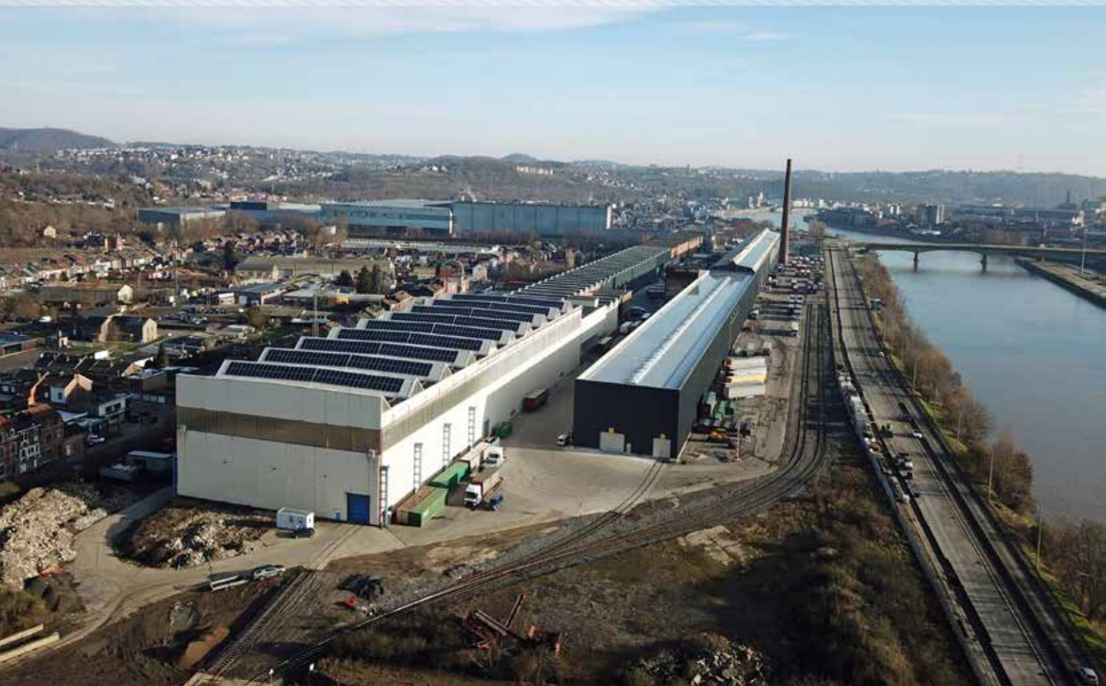
Le raccordement ferré de la société Greg Transports à Flémalle (Liège). © Greg Transports
