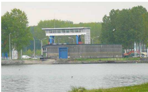
Photo 8.4-23 : écluse de Péronnes vue depuis les bords du Grand Large
