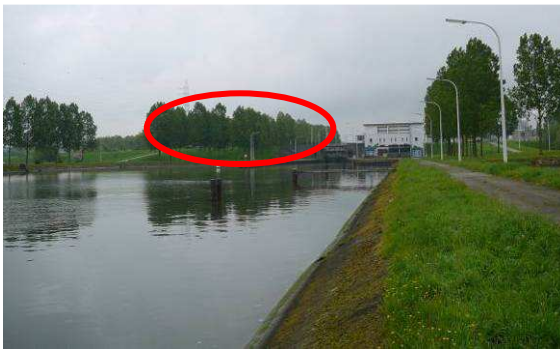
Photo 8.4-28 : écluse d'Obourg et mise en évidence de la localisation de la future écluse
