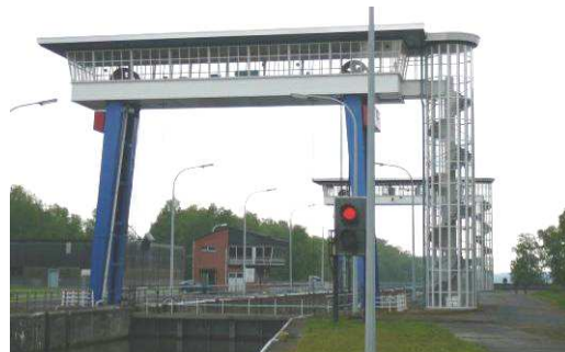
Photo 8.4-24 : écluse de Péronnes
