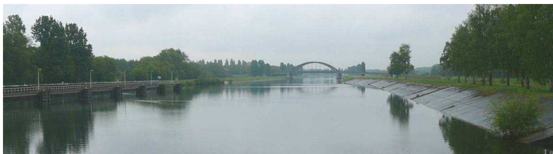
Photo 8.4-21 : vue sur le canal en amont de l'écluse d'Hensies
