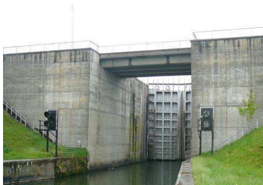
Photo 8.4-17 : porte de l'écluse de Pommeroeul
