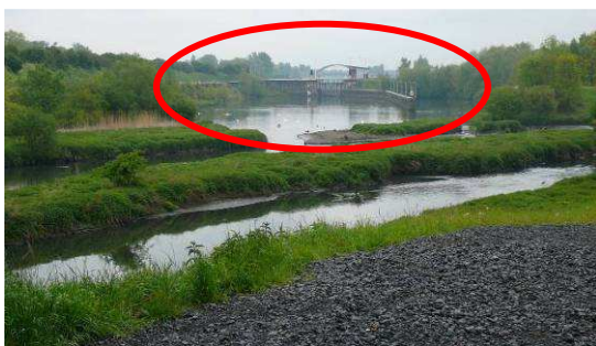
Photo 8.4-19 : vue du canal en aval de l'écluse d'Hensies
