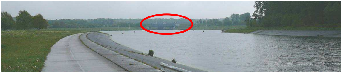
Photo 8.4-16 : vue du canal en aval de l'écluse de Pommeroeul
