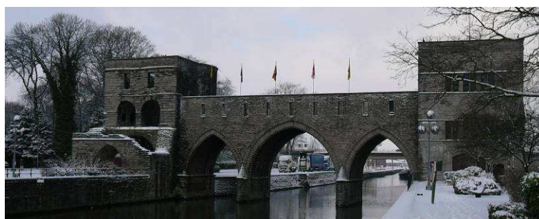
Photo 8.4-7 : Pont des Trous vu depuis le quai des Vicinaux
