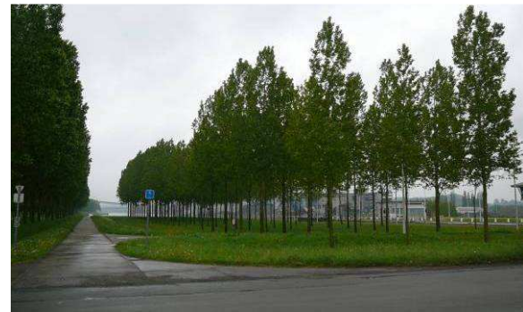
Photo 8.4-29 : emplacement de la future écluse
