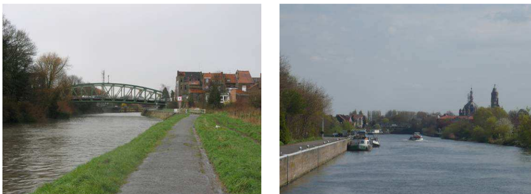
Photo 8.4-1: vue vers le pont de Comines depuis le chemin de halage en amont et en aval du pont
