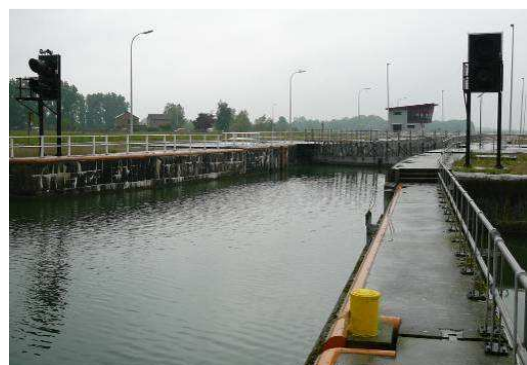
Photo 8.4-18 : écluse de Pommeroeul
