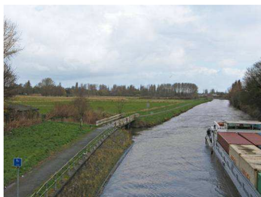
Photo 8.4-2 : vue vers les Prés de la Lys depuis le pont de Comines
