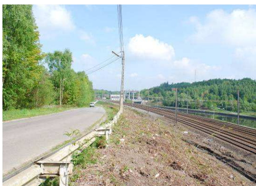
Photo 8.4-35 : vue sur l'écluse de Viesville depuis la rue Wartonlieu
