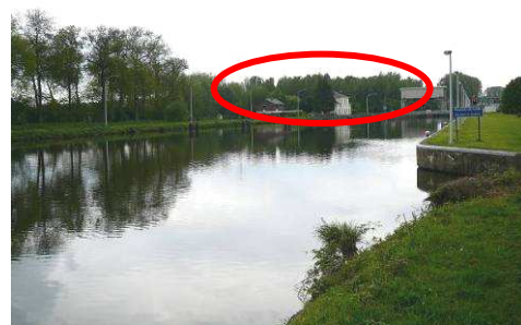
Photo 8.4-13 : vue de l'écluse et de la parcelle boisée depuis le Sud
