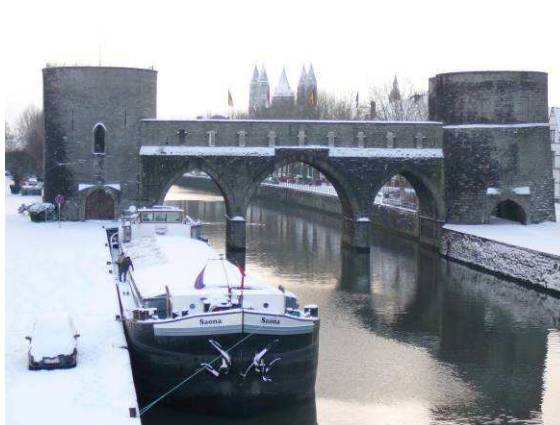
Photo 8.4-14: Pont des Trous vu depuis le boulevard Delwart
