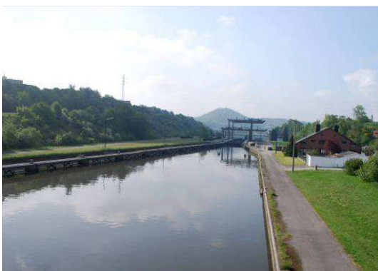
Photo 8.4-41 : vue vers l'écluse de Gosselies depuis le pont de la rue du Port.
