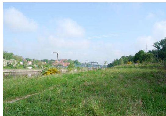
Photo 8.4-40 : écluse de Gosselies depuis la rue Léopold.
